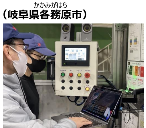
写真：現場で活躍する“ブリッジエンジニア”
