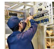
写真：作業の様子
